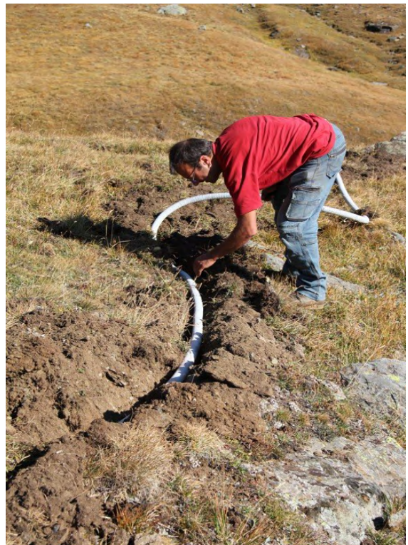
Una importante quota dei lavori eseguiti nel parco viene svolta in economia diretta dal personale dell'Ente. (Foto: B. Rosai)
