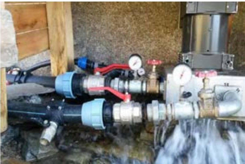
Molte manutenzioni vengono gestite internamente. Foto Archivio PNGP
